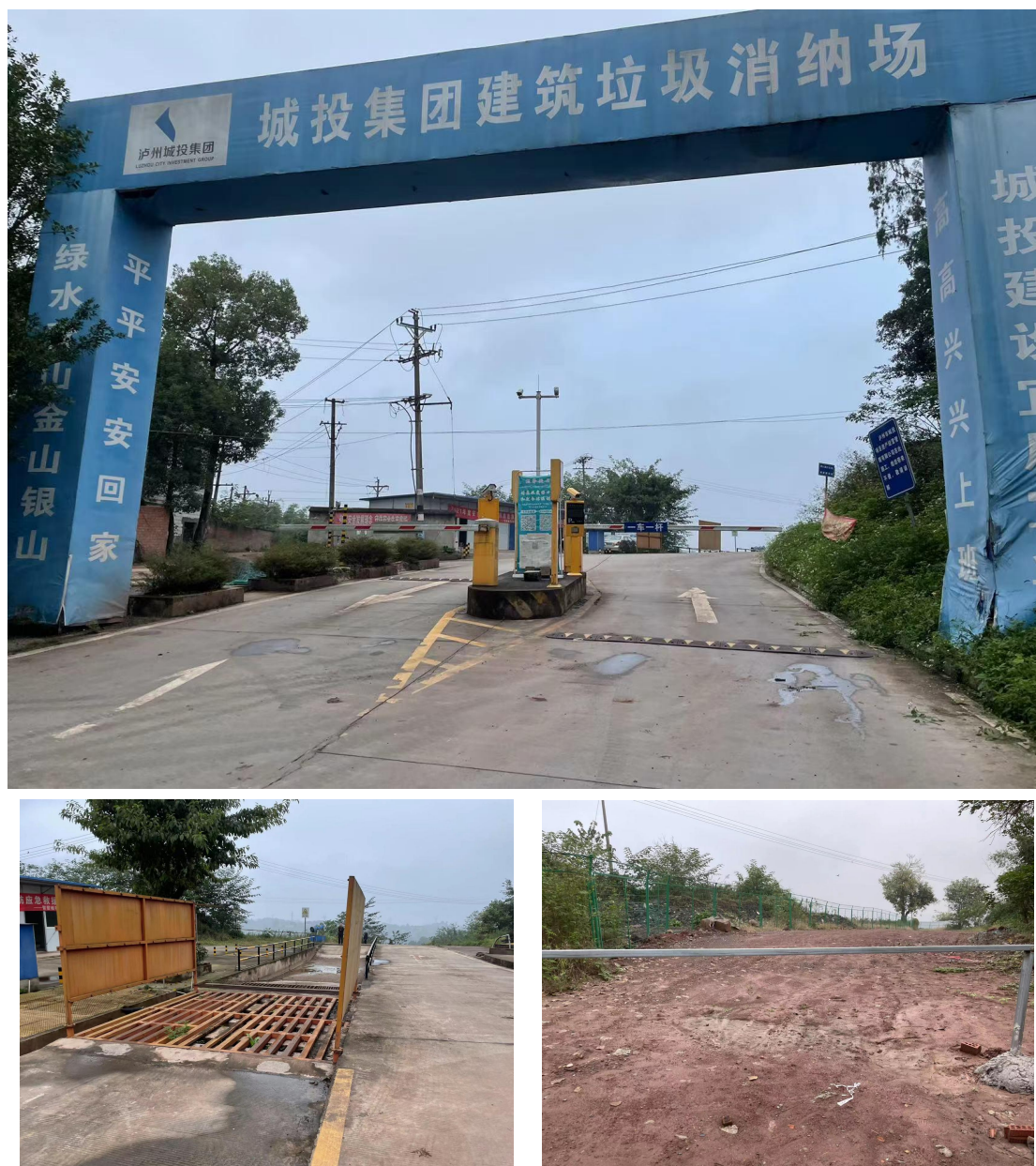
图 3-2 弃土场现场照片
